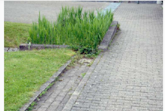
Tiefbeete mit Rigolen Quelle: BWVI (2015)
