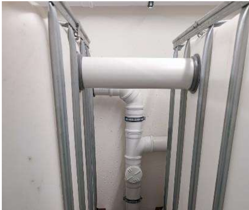
Verbindung der beiden Sammel tanks
