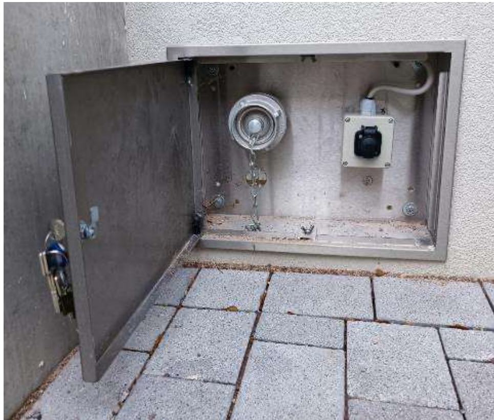
Anschluss im Außenbereich für den Grauwassertransport
