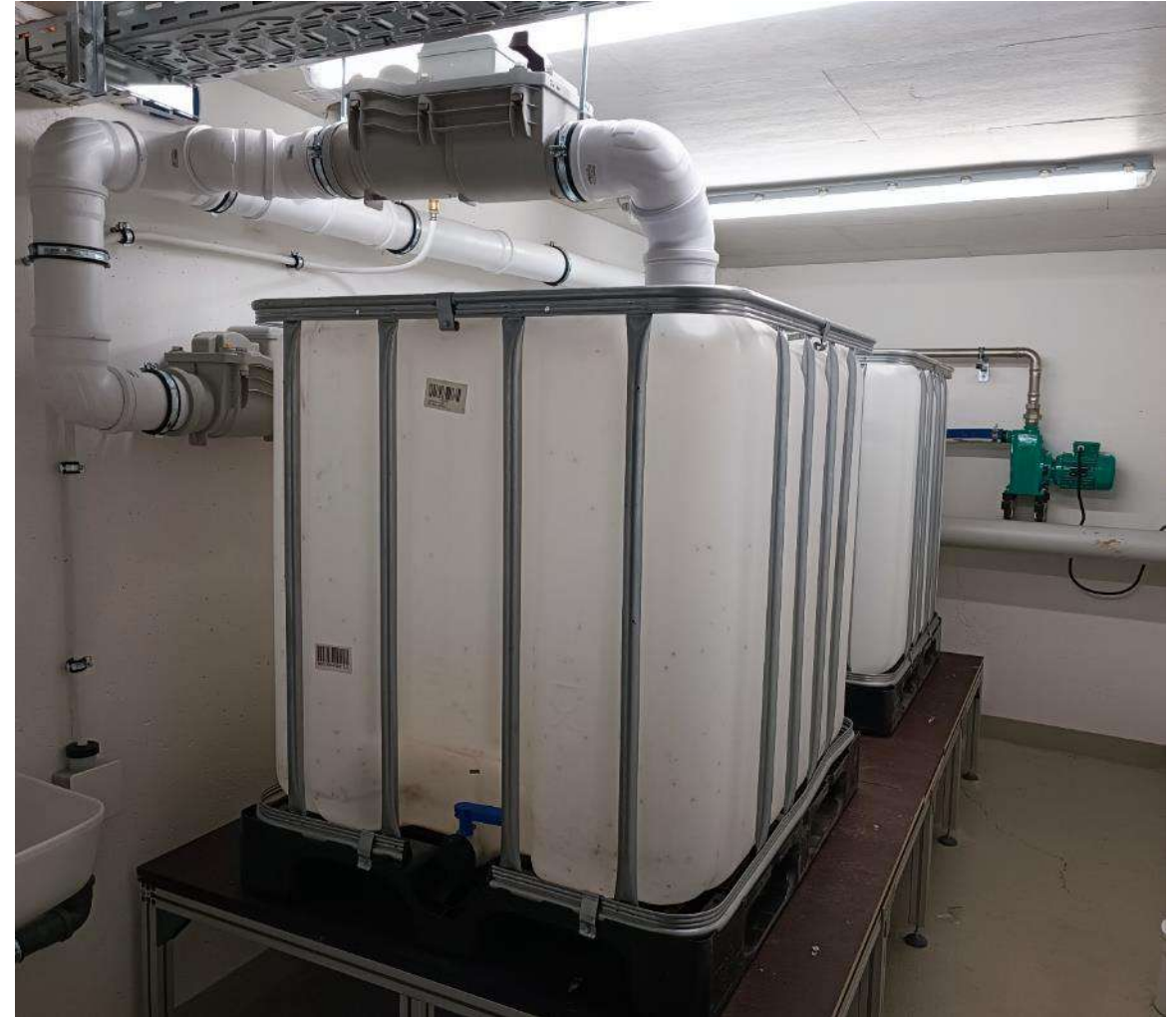
Grauwassersammeltanks im Keller eines Mehrfamilienhauses in Weimar
