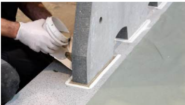
Abbildung 7 Vermörtelung der Stege mit der Brückenplatte, Quelle CPC AG
