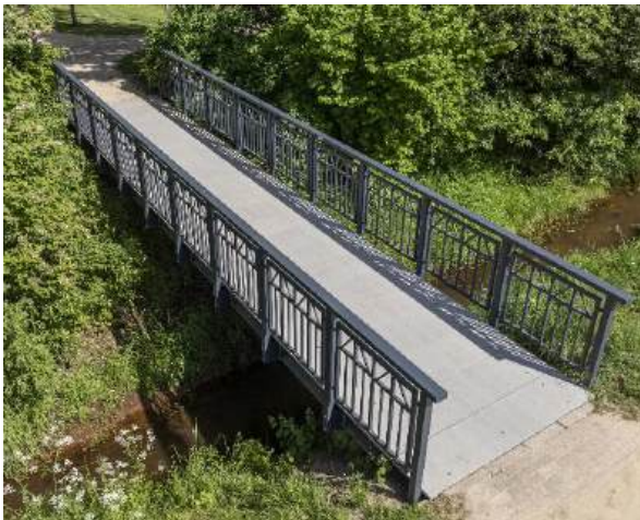
Abbildung 8 Brückensanierung Nadamer Bach, Essen, Quelle Holcim (Deutschland) GmbH
