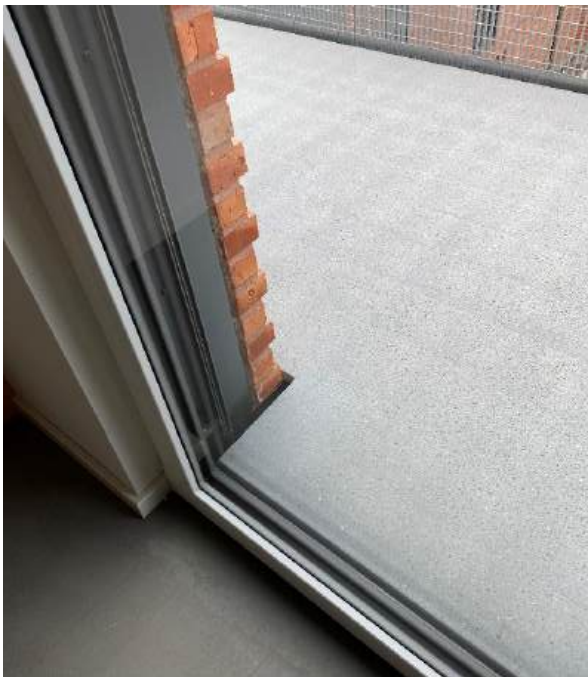
Abbildung 13 Barrierefreier Übergang beim Bauvorhaben „UBS4“, Quelle Holcim (Deutschland) GmbH
