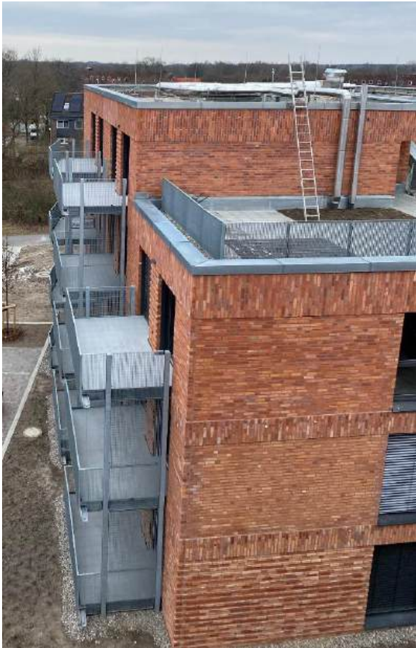
Abbildung 12 Balkone Bauvorhaben „UBS4“ Norderstedt, Quelle Holcim (Deutschland) GmbH
