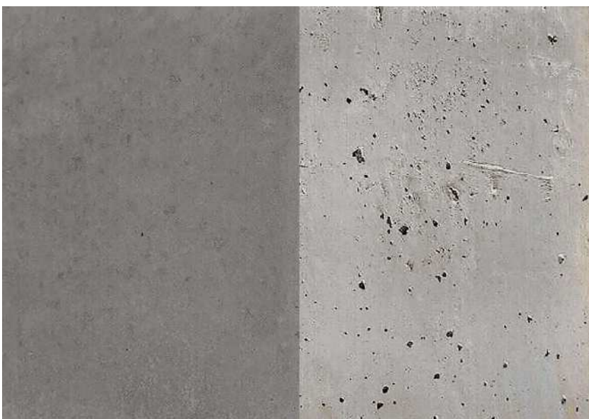
Bild 7: Betonergebnis, links mit Schalungsbahn Zemdrain® erstellt, rechts mit konventioneller Schalung erstellt
