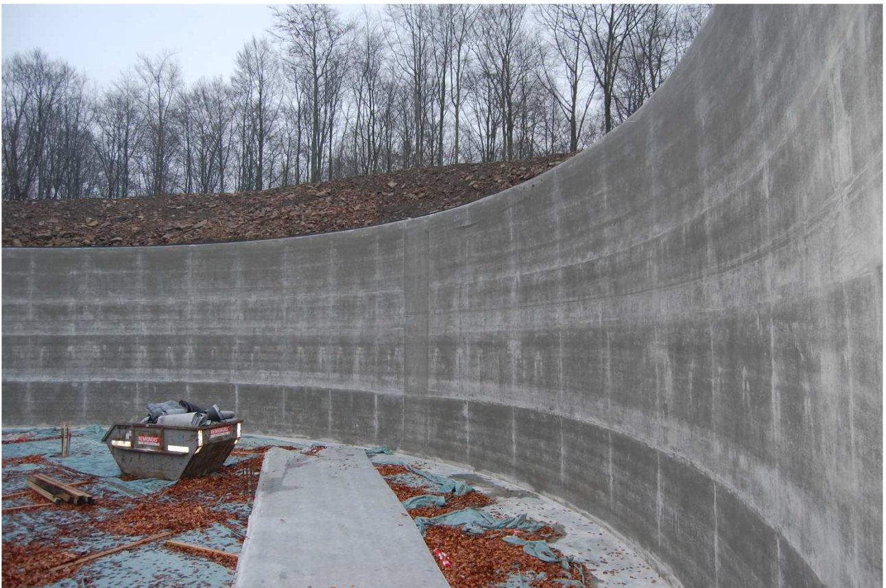
Bild 21: Hochbehälter Dortmund Höchsten – Ergebnis Betonage
