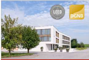
MAX FRANK Verwaltungsgebäude Leibfing
