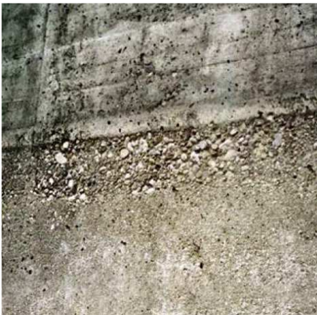
Bild 2: Schadensbild Beanspruchung durch Klärwasser
