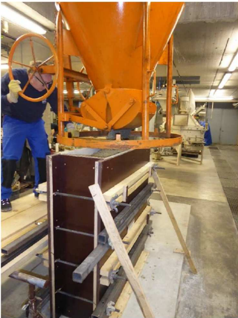
Bild 11: Verfüllen der geschalteten Wände mit Beton
