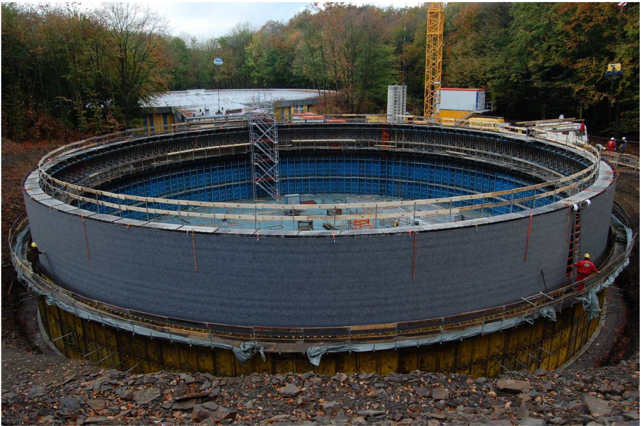
Bild 20: Hochbehälter Dortmund Höchsten – Schalungsbahn Zedrain® Classic montiert
