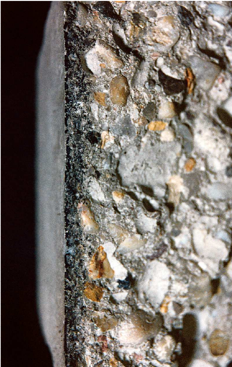
Bild 8: Detailaufnahme im Labor – reduzierter W/Z-Wert an der Betonoberfläche
