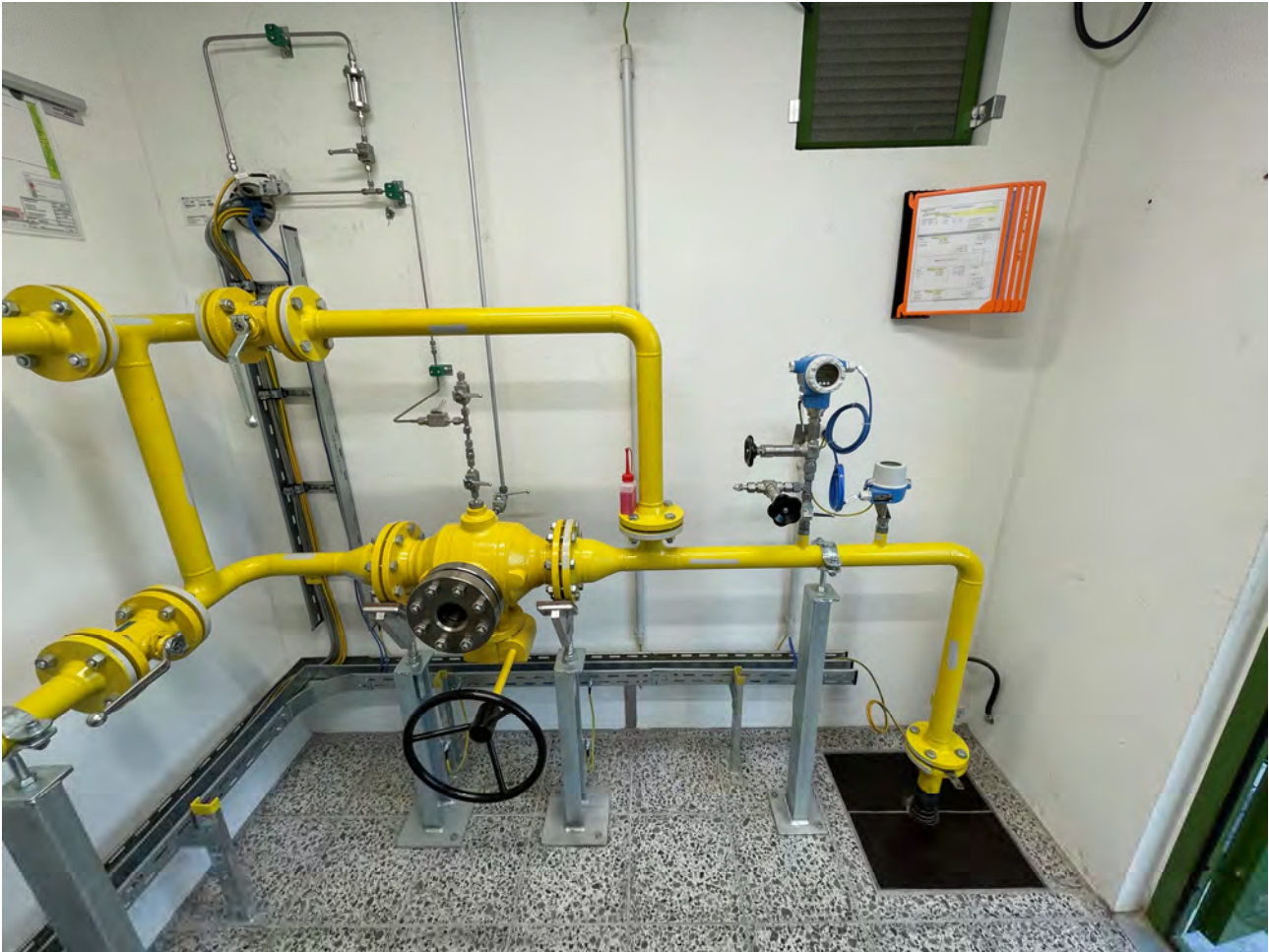
Bild 3: Ausgangsschiene mit patentierter Odoriervorrichtung
