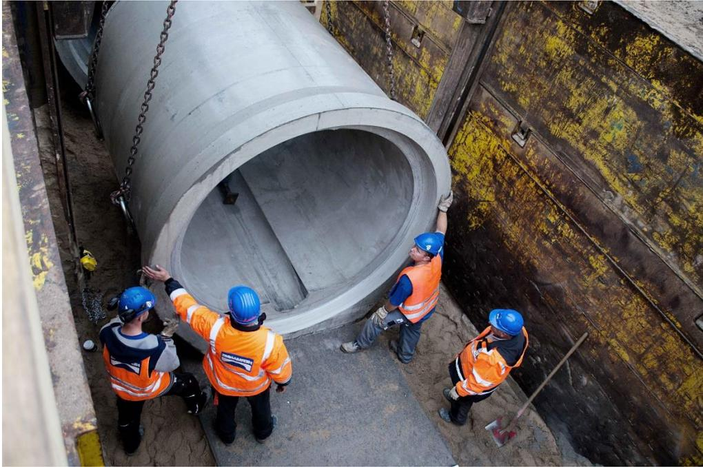
Abb. 1: Beispiel eines Stahlbetonrohres DN 2400 mit Trockenwetterrinne (Quelle: Betonwerk Bieren).
