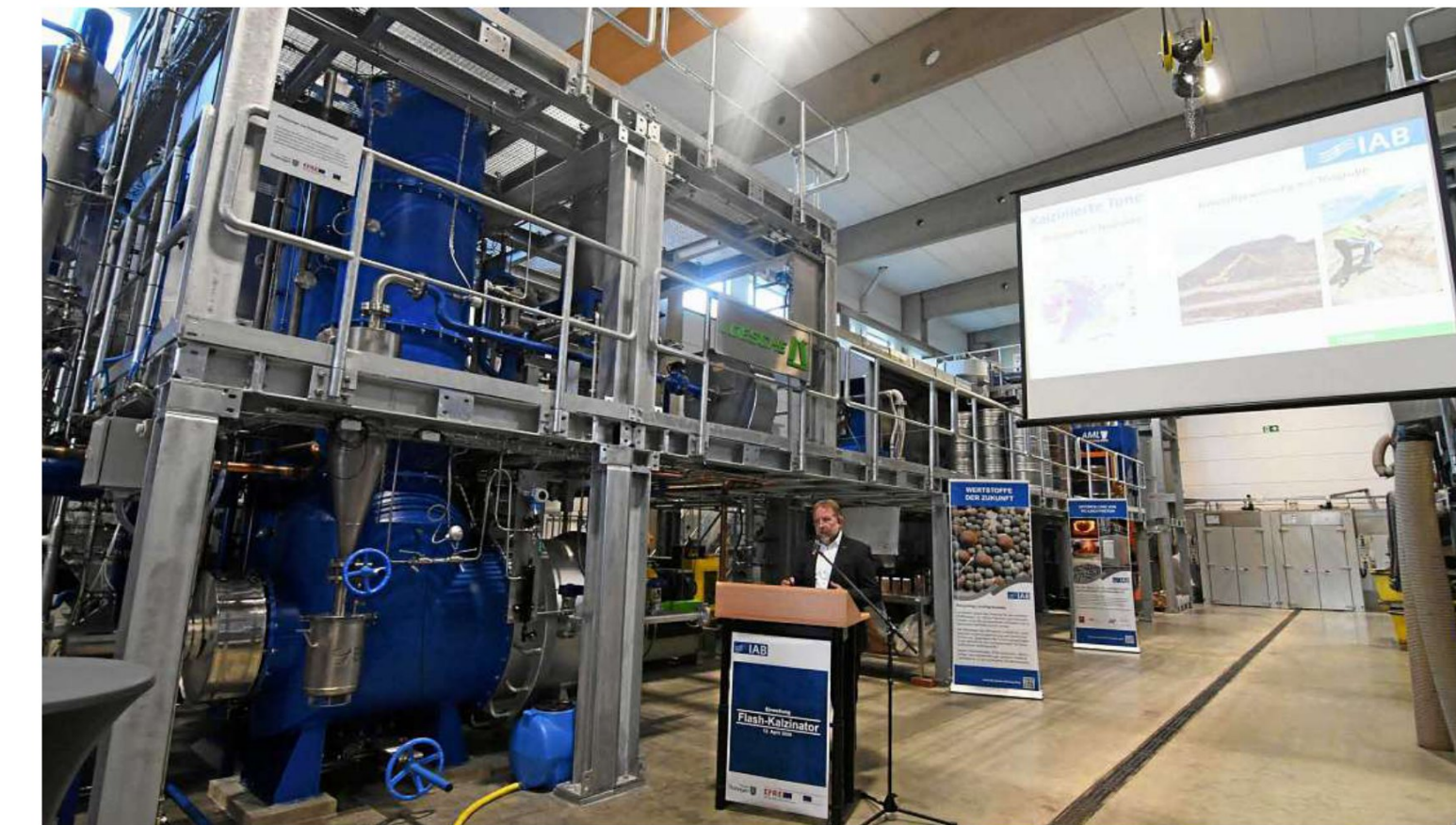
IAB-Direktor Ulrich Palzer erläuterte im Tröbsdorfer Technikum die Funktionsweise des neuen von der Loesche GmbH gebauten „Flash Kalzinators“.
