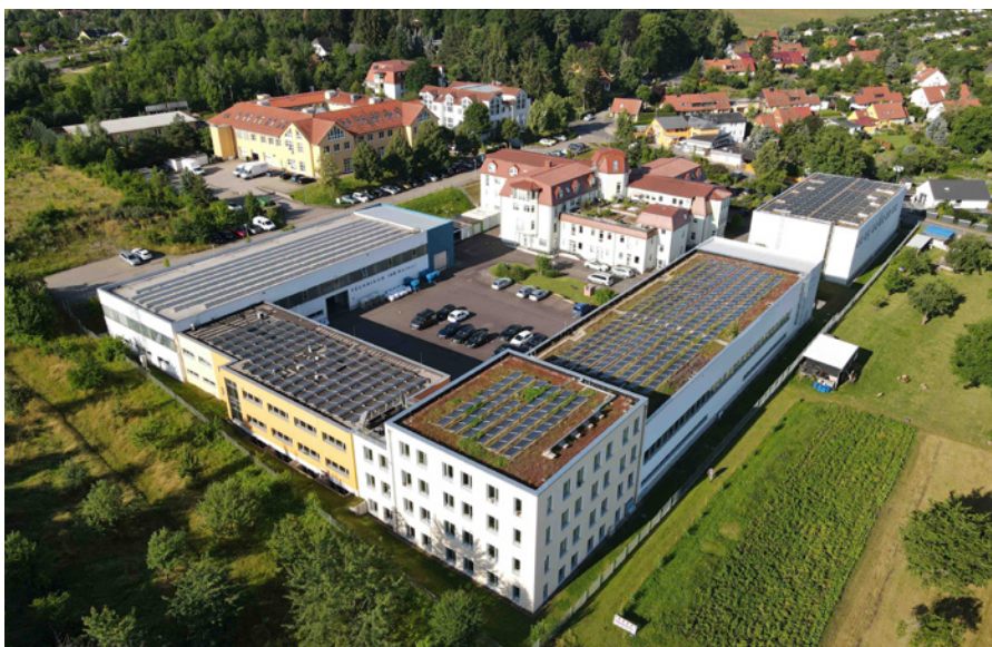
Luftaufnahme vom Institut für Angewandte Bauforschung (IAB) in Weimar
