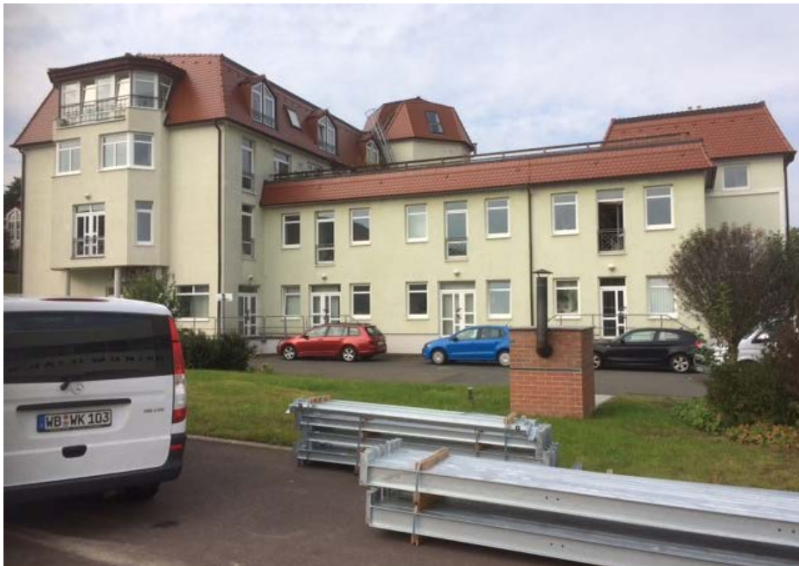
Bild 1: Haus 1: Haupthaus mit separater Einbruchmeldeanlage
