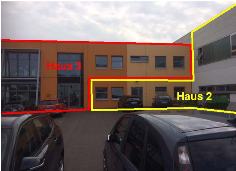
Bild 2: Haus 2 (Technikum I) und Haus 3 (Laborgebäude)
