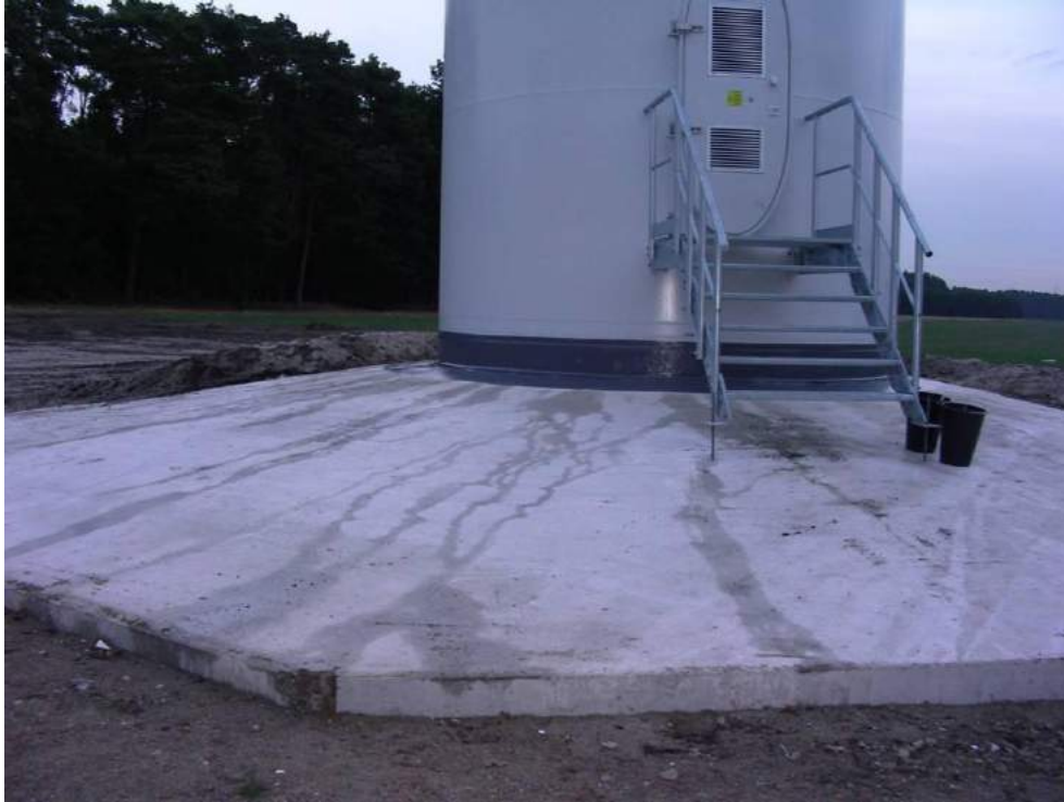
Bild 5: Flachfundament einer WEA
