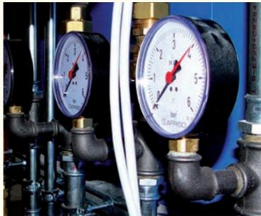
Drucküberwachung von Lufterdwärmetauschern
