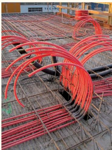
Bauteilaktivierung einer Geschosdecke zur Heizung und Kühlung eines Bürogebäudes
