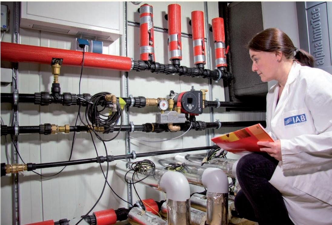
Langzeiterprobung durch einen Versuchsaufbau auf dem Gelände des IAB: Kälte-Wärme-Speicher zur Nutzung von regenerativen Energien
