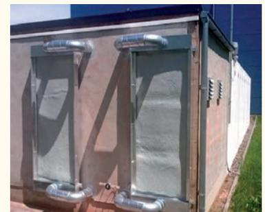
Energiegewinnung über die Fassade per Warmluft-Kollektor
