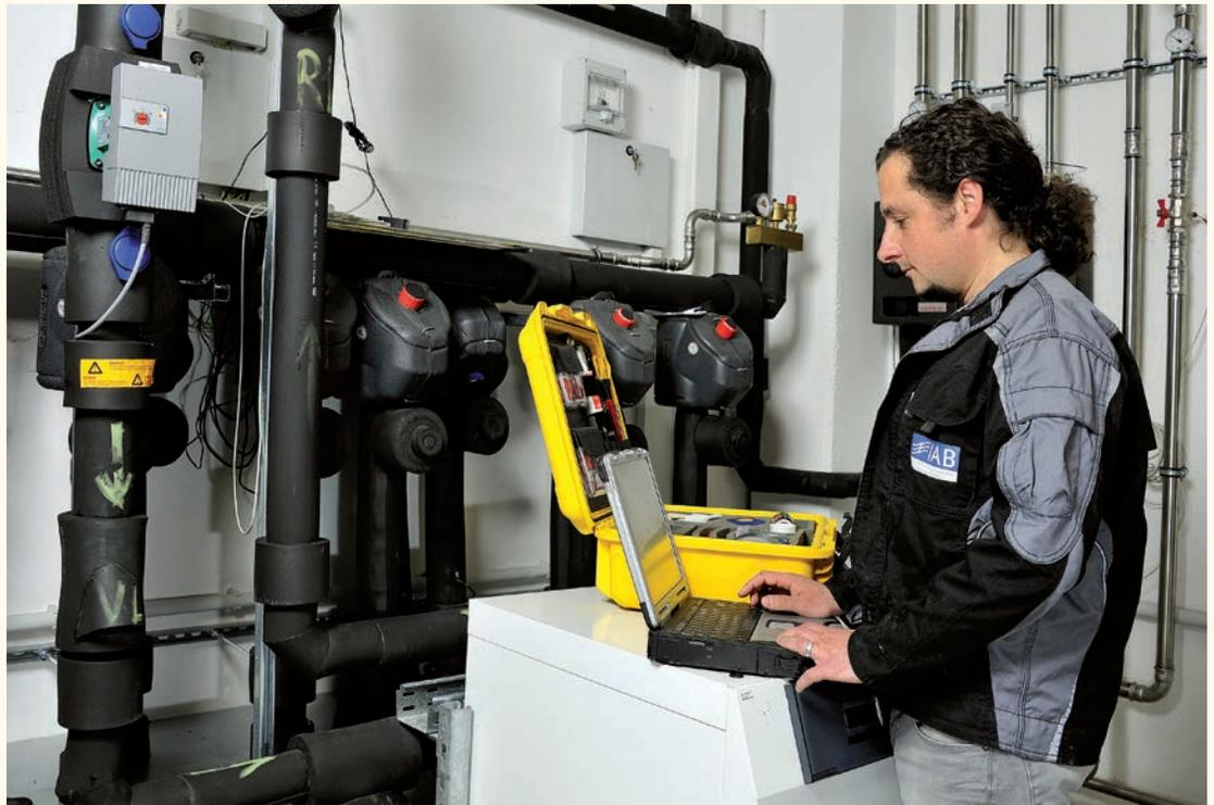
Geothermische Anlage mit sieben Erdwärmesonden im IAB-Laborgebäude sowohl zur Wärmeversorgung als auch für eine Langzeitstudie
