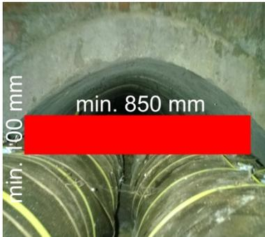
Um mit dem Inspektionsgerät „Crawler-Eye“ Fernwärmekanal zu inspizieren, wird ein Mindestfreiraum benötigt:
